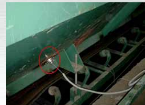
FSV in in der Wandung eines Wiegebehälters
