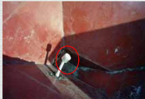
Armsonde FSA innenansicht des Silo
