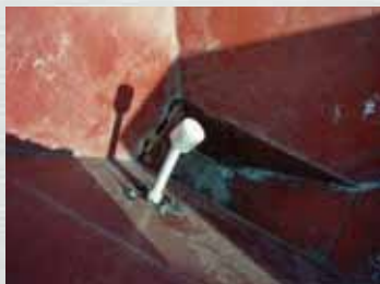
Armsonde FSA in einem Silo (Leer)
