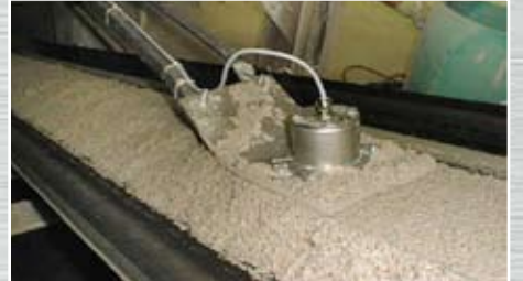
FSV - Sensor auf einem Förderband mit einem Gleitschlitten
