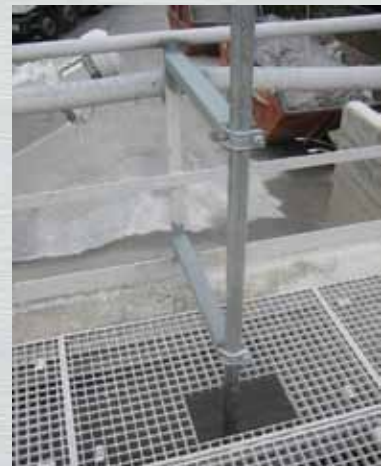
Angeschweisste Gerüstschellen mit bereits montiertem Halterungsrohr zum Messkopf
