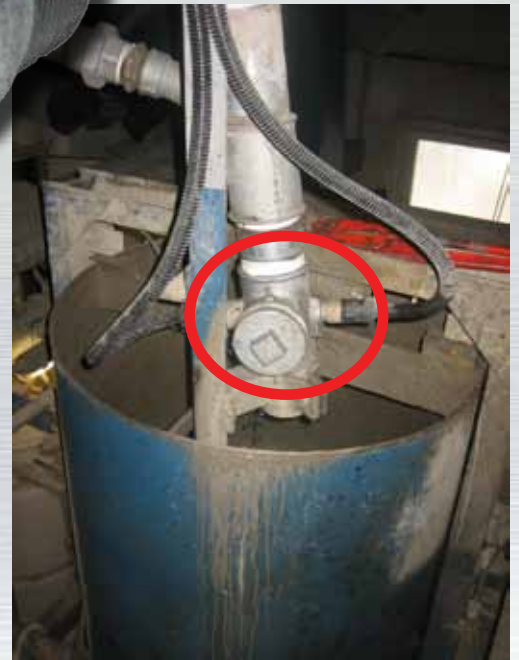
Abb.: 2,5" Restwasser-Leitung - Einfache Messkopf-Ausführung mit schraubbarem Verschluss
