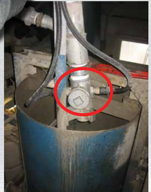
Abb.: 2,5" Restwasser-Leitung - Einfache Messkopf-Ausführung mit schraubbarem Verschluss
