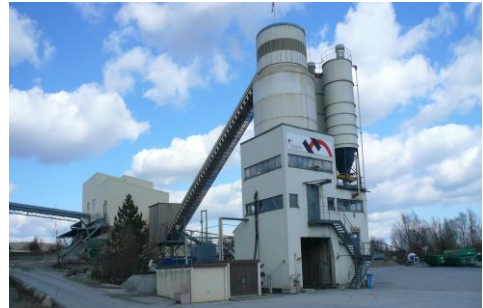
Betonanlage der HOLCIM Kies- und Beton AG in Dissenhofen/CH
